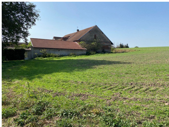
pohled na pozemek p.č. 561/3 z východní strany
