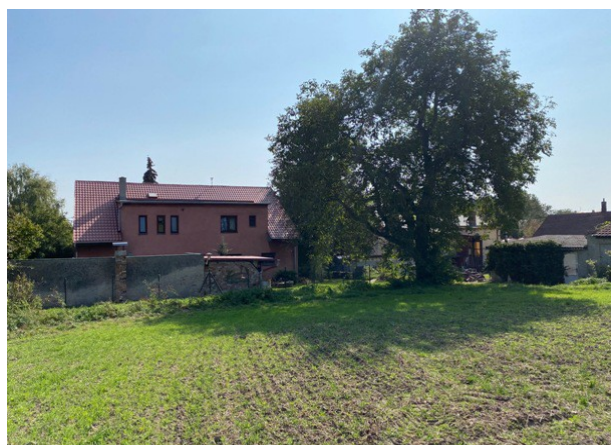
pohled na č.p.50 – prodejnu ze severní strany
