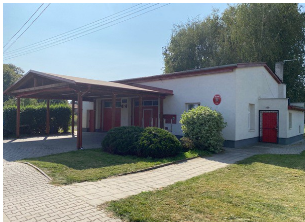
celkový pohled ze severovýchodní strany
