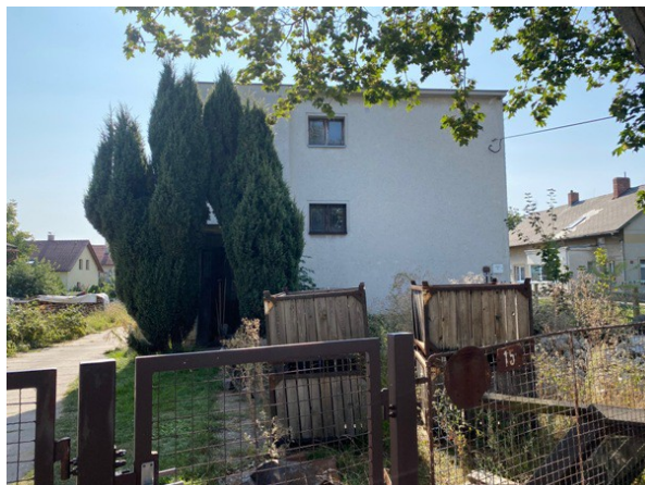
vstup do objektu ze severní strany
