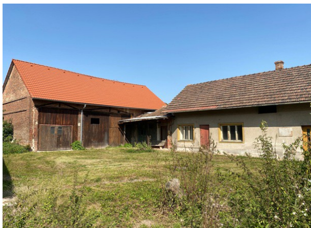
pohled do dvora na RD a stodolu z jižní strany
