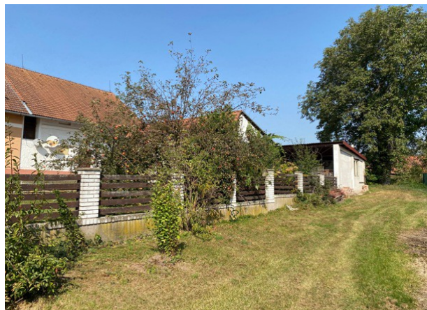
pohled vjezdu podél č.p.9 na pozemek 561/3 ze záp. strany
