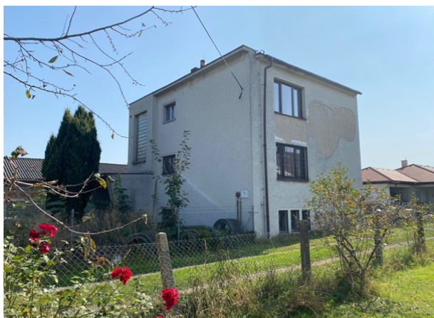
celkový pohled ze severozápadní strany
