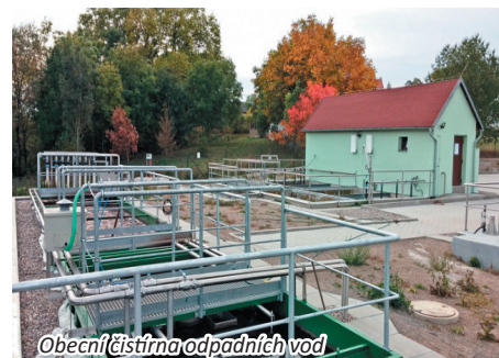
Obecní čistírna odpadních vod
